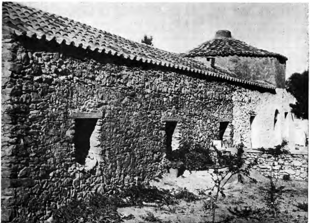
Ἄττική. Ἅγιος Ἰωάννης ὁ Θεολόγος: α. Ἡ καμάρη τῆς Τραπεζῆς κατὰ τὰς ἐργασίας ἀποκαταστάσεως, β. Ἡ Τράπεζα τῆς Μονῆς μετὰ τὴν ἀποκατάστασιν τῆς στέγης
