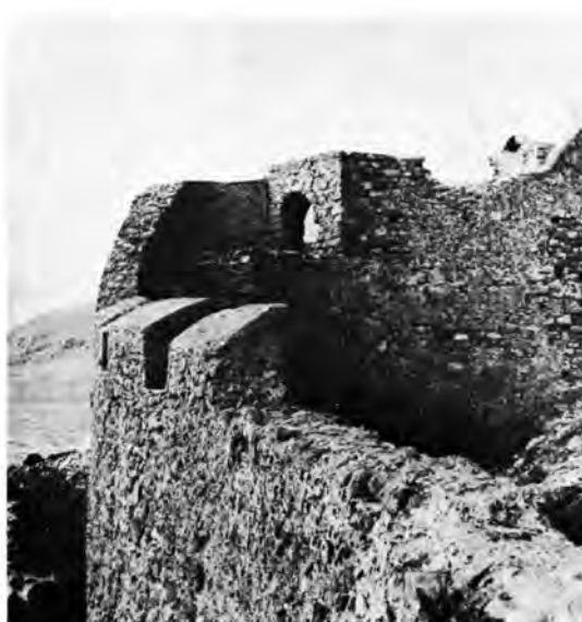
Μονεμβασιά: α - β. Τμήμα παρά την μικράν πόλιν κατά τήν στερέωσιν καί μετά ταύτην, γ. Τò στερεωθέν παρά τήν θέσιν «Πορτέλο» τμήμα τῶν τειχῶν μέ τὰς ὀδοντωτάς ἀπολήξεις, δ. Στερέωσις ὀδοντωτῶν ἀπολήξεων τῶν τειχῶν
