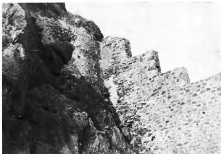
Λακωνία. Κάστρον Μονεμβασίας: α. ΝΔ. πλευρά τείχους. Τὸ ἐπισκευασθὲν τμήμα, β. Ἐπισκευασθεῖσα «καμάρα» ἐσωτερικοῦ τείχους, γ. Τὸ ἐπὶ τῶν βράχων ἐδραζόμενον ἐπισκευασθὲν τμήμα τοῦ Κάστρου
