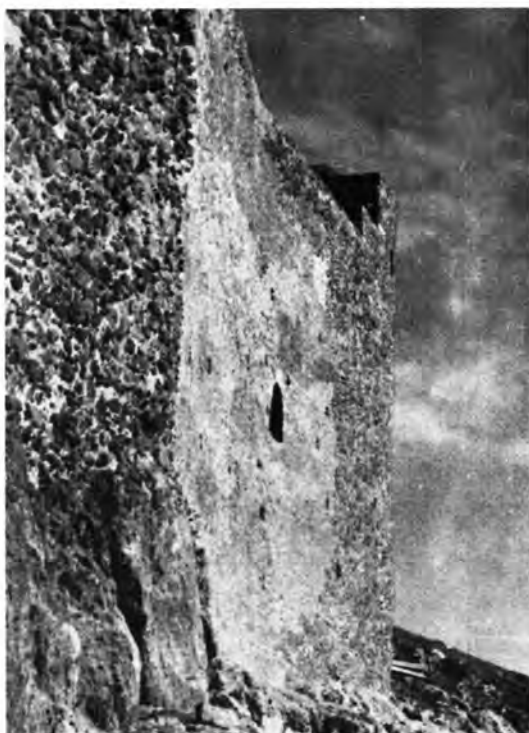
Λακωνία. Κάστρον Μονεμβασίας: α. Ἐσωτερικὸν τμήμα βορείας πλευρᾶς τείχους μετὰ τὴν ἐπισκευήν, β. Ἀνατολικὴ ἐσωτερικὴ πλευρὰ τείχους κατὰ τὴν διάρκειαν τῶν ἐργασιῶν στερεώσεως, γ. Ἀνατολικὴ ἐξωτερικὴ πλευρὰ τείχους μετὰ τὴν ἐπισκευήν
