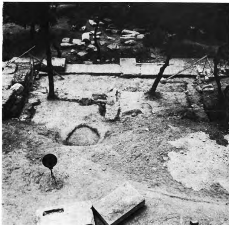
Ἀθήναι. Στοά Εὐμένους: α. Ὁ χώρος πρὸ τῶν ἐργασιῶν διαμορφώσεως, β. Οἰκία κατὰ τὴν ΝΑ. γωνίαν
