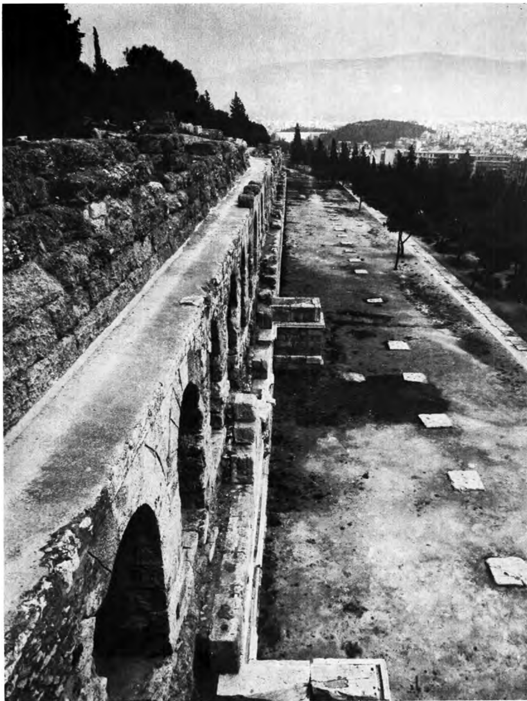
Ἀθήναι. Στοά Εὐμένους: Ὁ χώρος μετὰ τὰς ἐργασίας διαμορφώσεως
