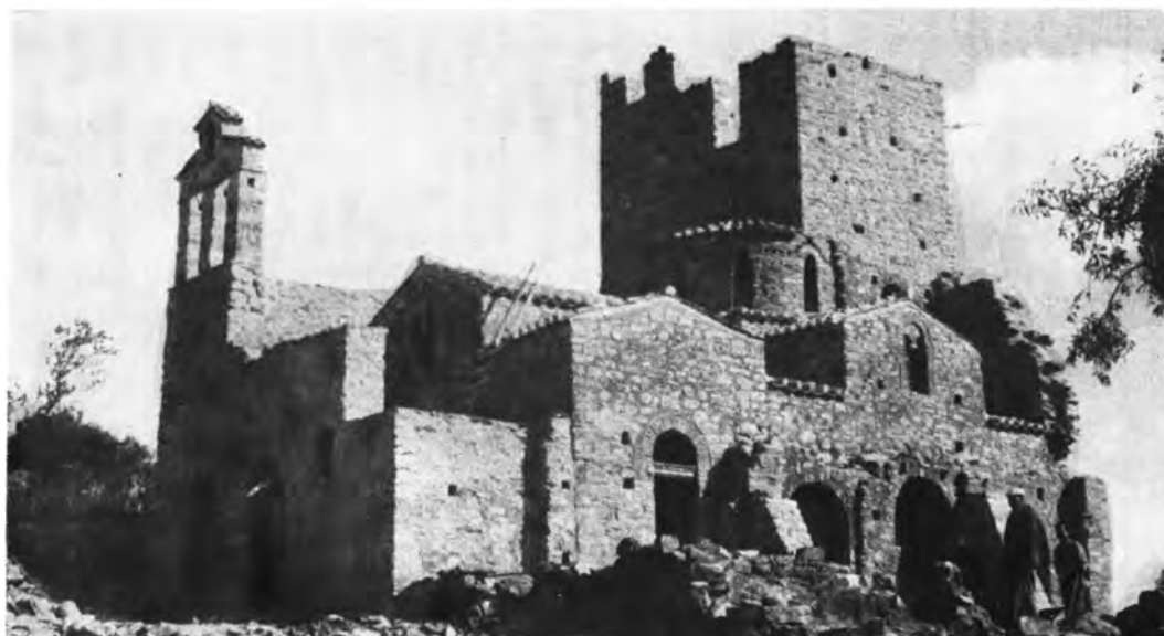
Λακωνία. Ναός της Χρυσοφειτίσσης: α - β. Ή Α. πλευρά τοῦ πύργου καὶ ὁ ναὸς μετὰ τὴν στερέωσιν
