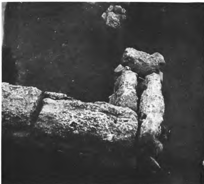
Ἡλεία. Μακρύσια. Τομεὺς Β' : α - β. Ὑποψη τοῦ ἀποκαλυφθέντος οἰκοδομήματος καὶ λεπτομέρεια αὐτοῦ
