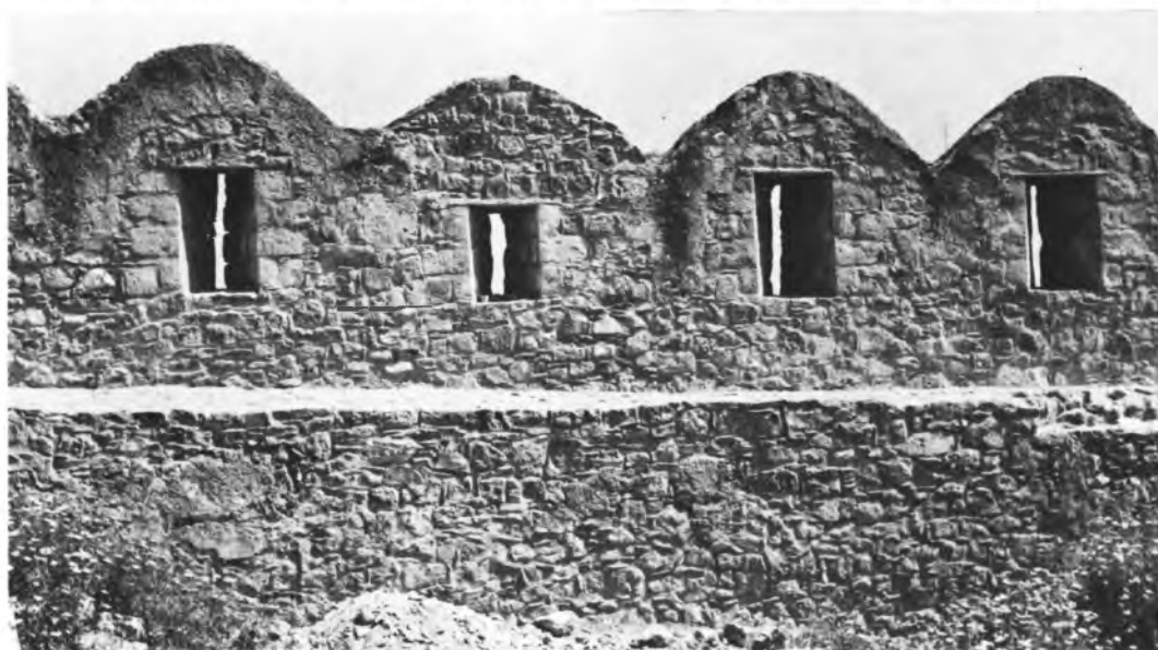
Χαλκίς. Φρούριον Εὐρίπου: α. Ἀποψὶς τοῦ φρουρίου πρὸ τῶν ἐργασιῶν, β - γ. Τὸ Β. σκέλος τοῦ τείχους πρὸ καὶ μετὰ τὰς ἐργασίας
