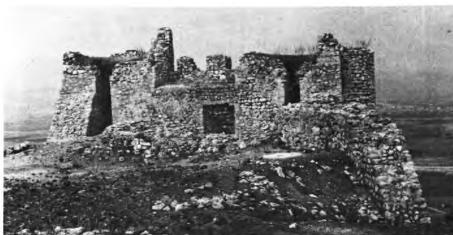
Ἄργολις. Λάρισα Ἄργους: α - β. Οἱ δίδυμοι πύργοι πρὸ καὶ μετὰ τὰς ἐργασίας, γ. Οἱ δίδυμοι πύργοι καὶ δεξιὰ τὸ ἀρχαῖον πολυγωνικὸν τεῖχος, δ. Τὸ συγκρότημα τῶν διδύμων πύργων ἐκ τοῦ ἐσωτερικοῦ τῆς Λαρίσης
