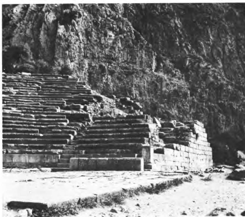
Δελφοί: α - β. Τò θέατρον πρό καί μετά τὰς ἐργασίας συντηρήσεως
