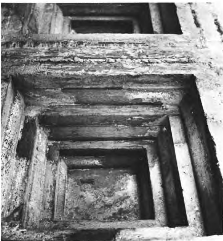
Ἀθήναι : α - β. Τμήμα τῆς φανωματικῆς ὀροφῆς τῶν Καρυατίδων τοῦ Ἑρεχθείου, πρὸ καὶ μετὰ τὰς ἐργασίας συντηρήσεως
