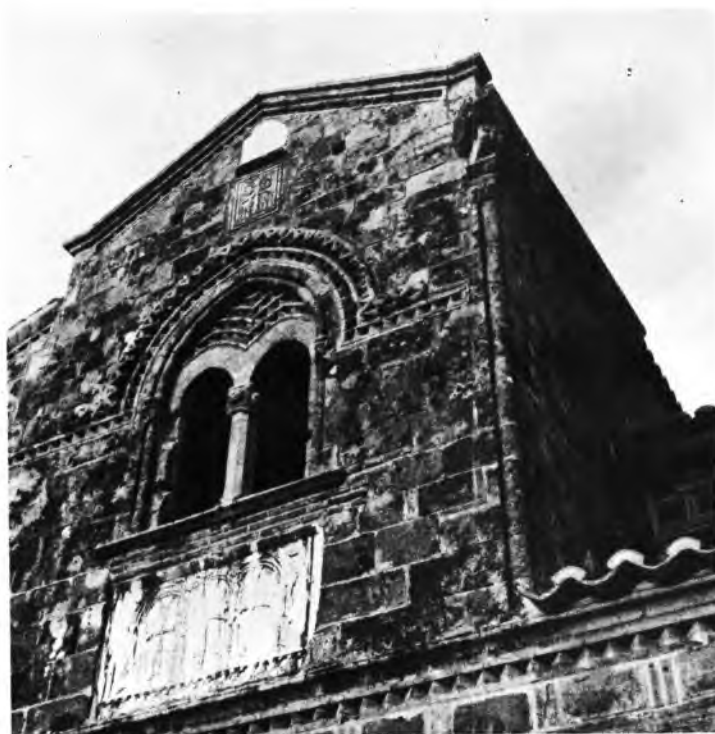
Κυλλήνη, Μονή Βλαχερνών: α - β. Ἡ Ν. ὄψις τοῦ νάρθηκος πρὸ καὶ μετὰ τὰς ἐργασίας
