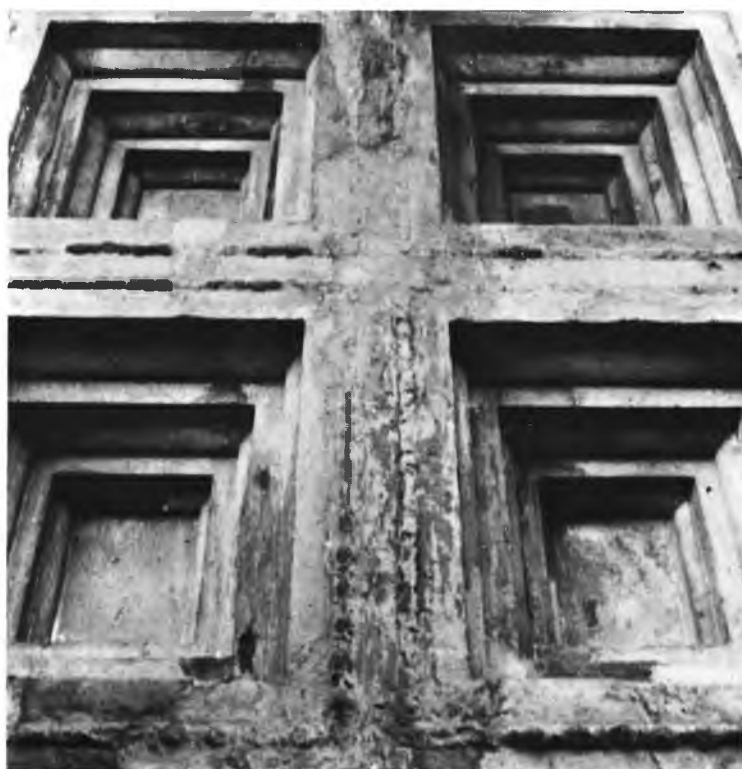
Ἀθήναι : α - β. Τμήμα τῆς φατνωματικῆς ὀροφῆς τῶν Καρυατίδων τοῦ Ἑρεχθείου, πρὸ καὶ μετὰ τὰς ἐργασίας συντηρήσεως
