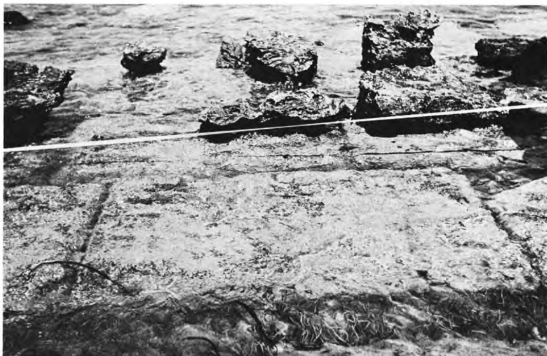
Agina : a. Blick von der Strasse auf Punkt "L" in A b b. 8. Die unvermörtelten Quaderfundamente liegen im Wasser. Es schauen die vermörtelten Teile heraus, b. Detail des grossen Fundamentes "L" das in A b b. 9 gezeigt wird
