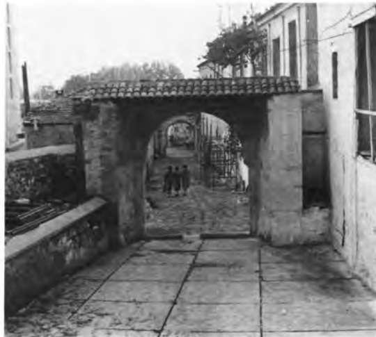
α) Δράμα. Τμήμα του βυζαντινού τείχους μετά τις εργασίες, β) Καβάλα. Ανακατασκευή των επάλξεων του τείχους της ακρόπολης, γ) Καβάλα. Η ανοιχτή στοά του Αγίου Ιωάννη μετά τις εργασίες συντήρησης.
