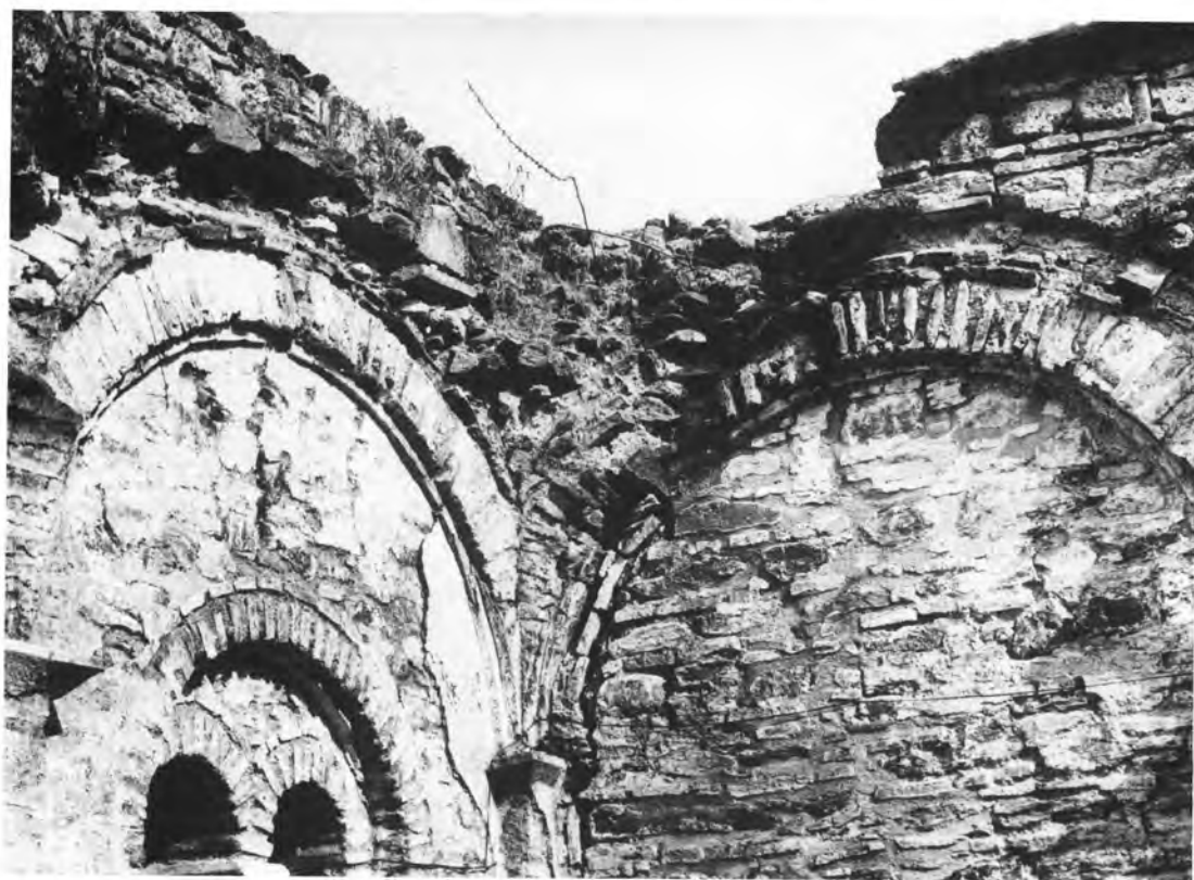
Στόμιο (Τσάγεζι). Μονή Αγίου Δημητρίου: α) Λιτή. Νοτιοδυτική γωνία, β) Δυτική πλευρά.
