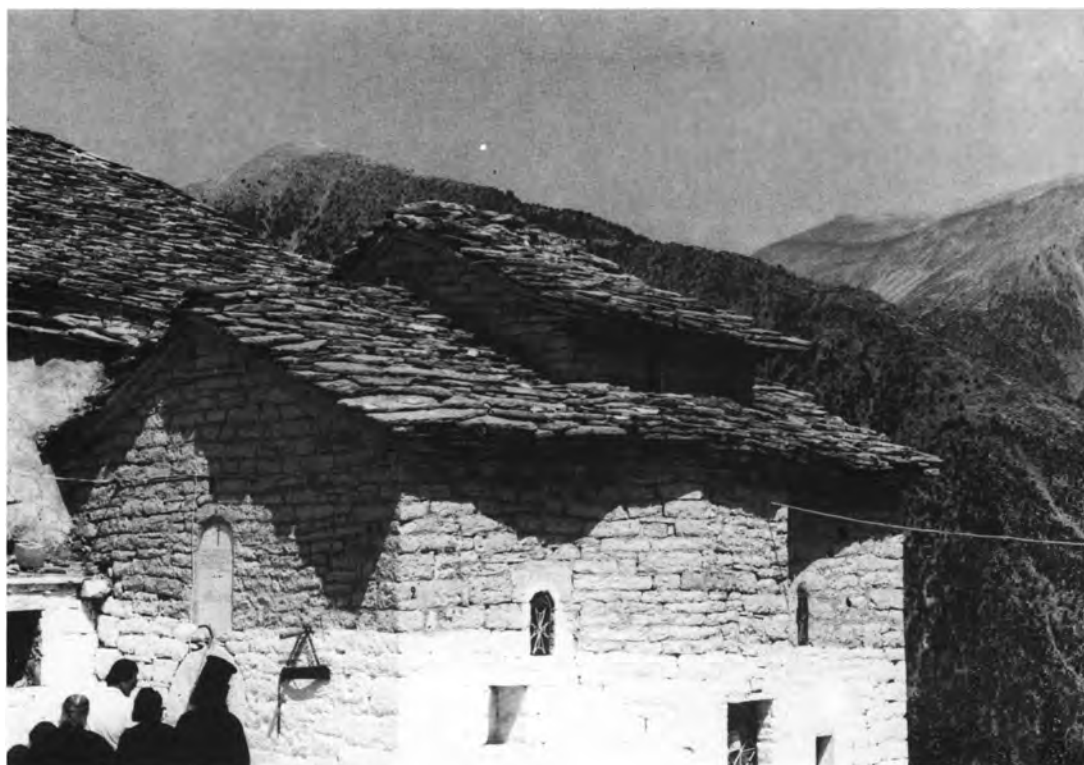
Ανατολική Αργιθέα. Μονή Παναγιάς Σπηλιάς: α-β) Άποψη από Δ. και νότιο καθολικό.
