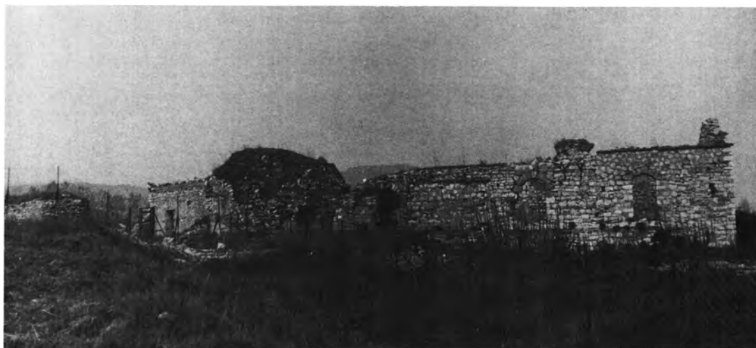
Κάστρο Ιωαννίνων: α) Δυτικό τμήμα του Μεντρεσέ Τζαμιού Ασλάν Πασά, κατά τη διάρκεια των εργασιών, β) Ιτζ-Καλέ. Μικρό λουτρό πριν από τις εργασίες.
