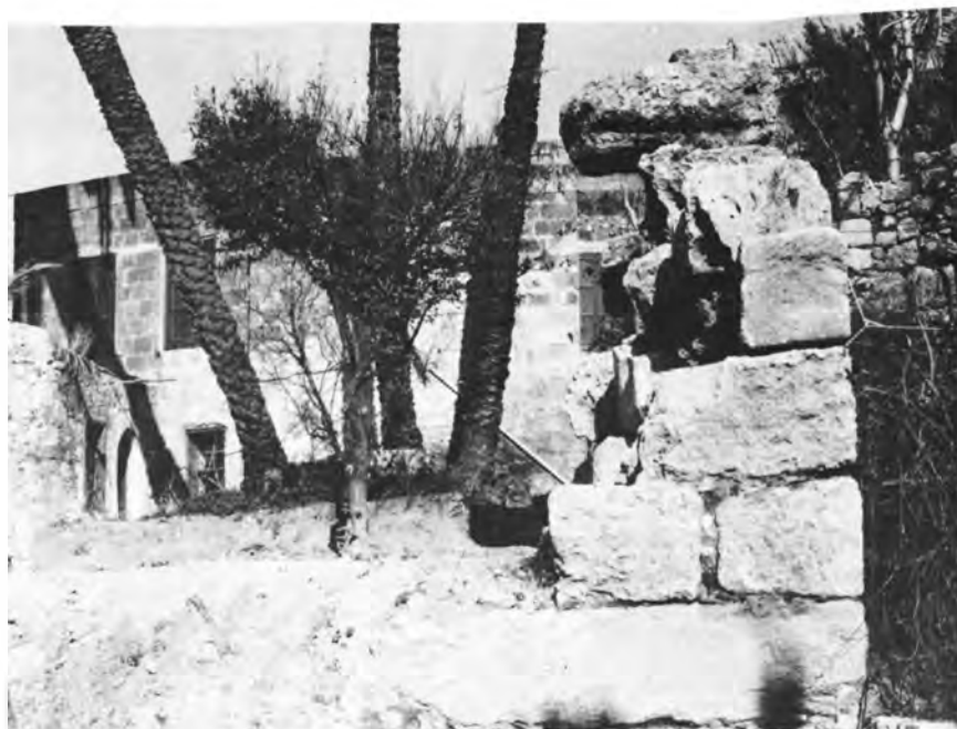
Ρόδος. Μεσαιωνική πόλη. Ο βυζαντινός πύργος στο οικόπεδο Σαμπίχα - Καϊμακτσή: α) Η εσωτερική παρεία της ανατολικής πλευράς του, β) Η νοτιοανατολική γωνία του.
