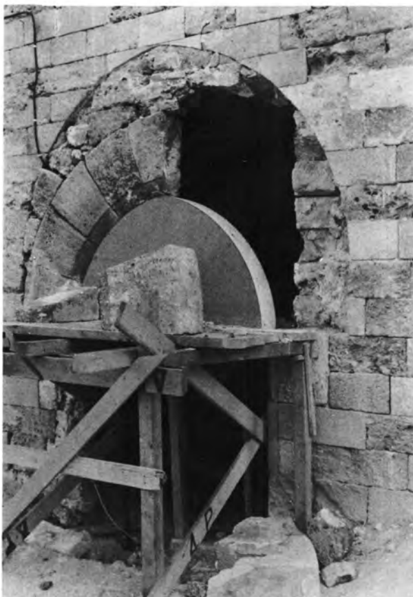
Ρόδος. Μεσαιωνική πόλη. Ιπποτικός ξενώνας Αγίας Αικατερίνης: α) Εσωτερικό άνοιγμα του ισογείου μετά την αποκατάσταση, β) Το κεντρικό θύρωμα της εισόδου κατά τη διάρκεια των εργασιών.
