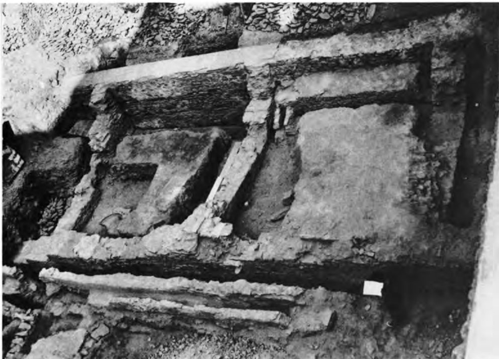
Θεσσαλονίκη. Οδός Αγίου Νικολάου 3: α) Λεπτομέρεια της τοιχοποιίας της πρόσοψης κτιρίου ανατολικά της ρωμαϊκής οδού, β) Κάτοψη τμήματος κτιρίου δυτικά της ρωμαϊκής οδού.
