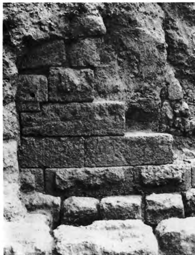
Ρόδος, Αρχαίο τείχος: α) Ο μνημειώδης αγωγός από Δ., β) Η εσωτερική όψη του νότιου τοιχώματός του αγωγού.
