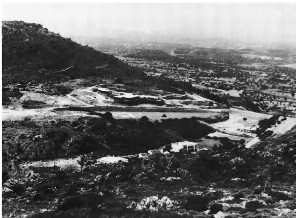
α) Ιαλυσός. Οικόπεδο Μ. Γιάννακα. Άποψη του κτίσματος από Δ.-ΝΔ., β) Λαδικό Καλυθιών. Η θέση Βαγιές και το Ερημόκαστρο.
