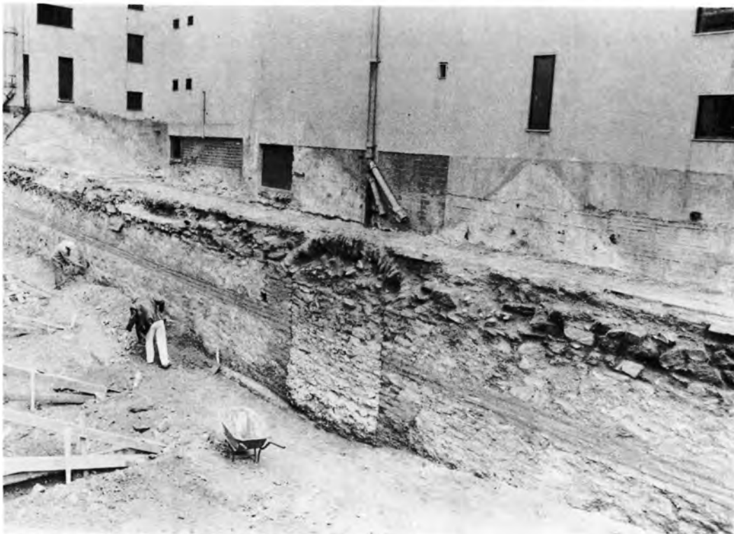
α) Νομός Πιερίας, Πύδνα. Σκάλα ανόδου στο Κάστρο, β) Θεσσαλονίκη. Οδός Φιλικής Εταιρείας 10. Τμήμα του ανατολικού προτειχίσματος.
