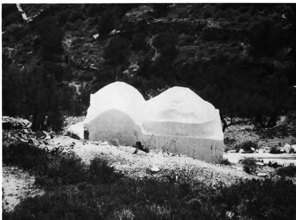
α) Ρόδος. Μεσαιωνική πόλη. Ιπποτικός ξενώνας Αγίας Αικατερίνης. Το κεντρικό θύρωμα της εισόδου, μετά την αποκατάσταση, β) Αμοργός. Κατάπολα. Ο ναός της Ευαγγελίστριας.
