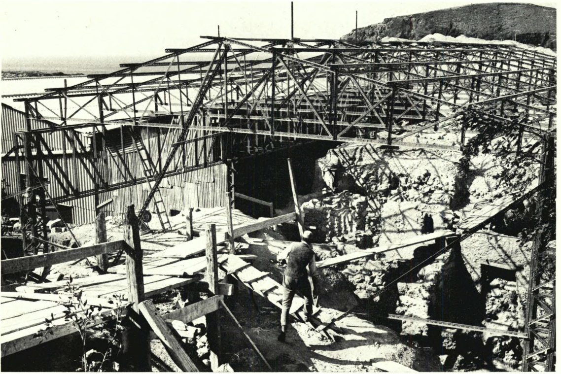
Είκ. 1. Τομέας Β, κατασκευή του στεγάστρου
