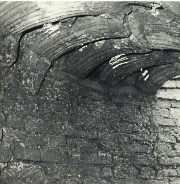
Είκ. 6. Λεπτομέρεια τῶν ἀεραγωγῶν σωλήνων τοῦ κεντρικοῦ στηρίγματος τοῦ κεραμικοῦ κλιβάνου ἐν Ἡλίδι
