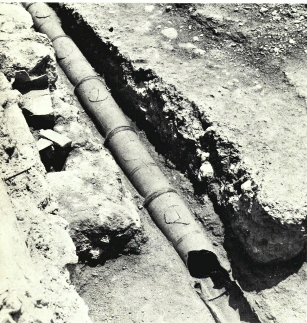
Εικ. 3. Ἀθήναι. Ὁδὸς Ἀδριανοῦ καὶ Θεσσαλίου. Τμήμα πηλίνου ἀγωγοῦ
