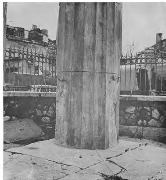
Ρωμαϊκή Ἀγορά. Πύλη Ἀρχηγέτιδος Ἀθηνᾶς. 1ος κίονας ἀπὸ Β.: α-β) Ὁ ἄβακας τοῦ κιονόκρανου πρὶν καὶ μετὰ τίς ἐργασίες, γ-δ) Ὁ 1ος καὶ 2ος σπόνδυλος (νοτιοανατολική ὁψη) πρὶν καὶ μετὰ τίς ἐργασίες.
