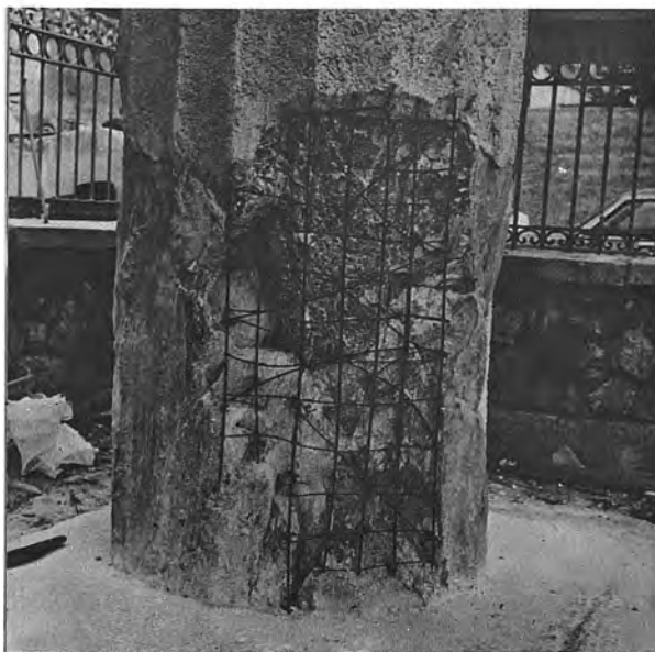
Ρωμαϊκή Ἀγορά. Πύλη Ἀρχηγέτιδος Ἀθηνᾶς. 1ος κίονας ἀπὸ Β.: α-β) Ὁ ἄβακας τοῦ κιονόκρανου πρὶν καὶ μετὰ τίς ἐργασίες, γ-δ) Ὁ 1ος καὶ 2ος σπόνδυλος (νοτιοανατολική ὁψη) πρὶν καὶ μετὰ τίς ἐργασίες.
