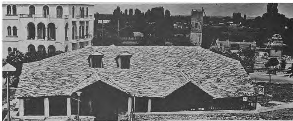
α-β) Θάσος. Λιμένας. Νότια πύλη μεσαιωνικής ακρόπολης πριν και μετά τις εργασίες, γ-δ) Ήλελυθερούπολη. Ναός Αγίου Νικολάου. Λεπτομέρεια στέγης και ή νότια πλευρά μετά τις εργασίες.
