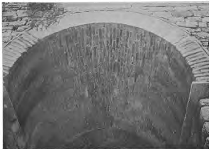
Νικόπολη. Βυζαντινά τείχη: α) Ἡ ἀνατολική πλευρά, β-γ) Ἰσολωτὴ κατασκευὴ τῆς ἀνατολικῆς πλευρᾶς πρὶν καὶ μετὰ τὶς ἐργασίες.
