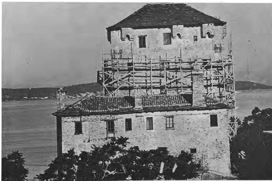
α) Άγιο Όρος. Μονή Σταυρονικήτα. Τοιχογραφίες καθολικού. Δείπνο στους Έμμαους. β) Ούρανούπολη. Μεσαιωνικός πύργος. Ή ανατολική όψη κατά τη διάρκεια των εργασιών.
