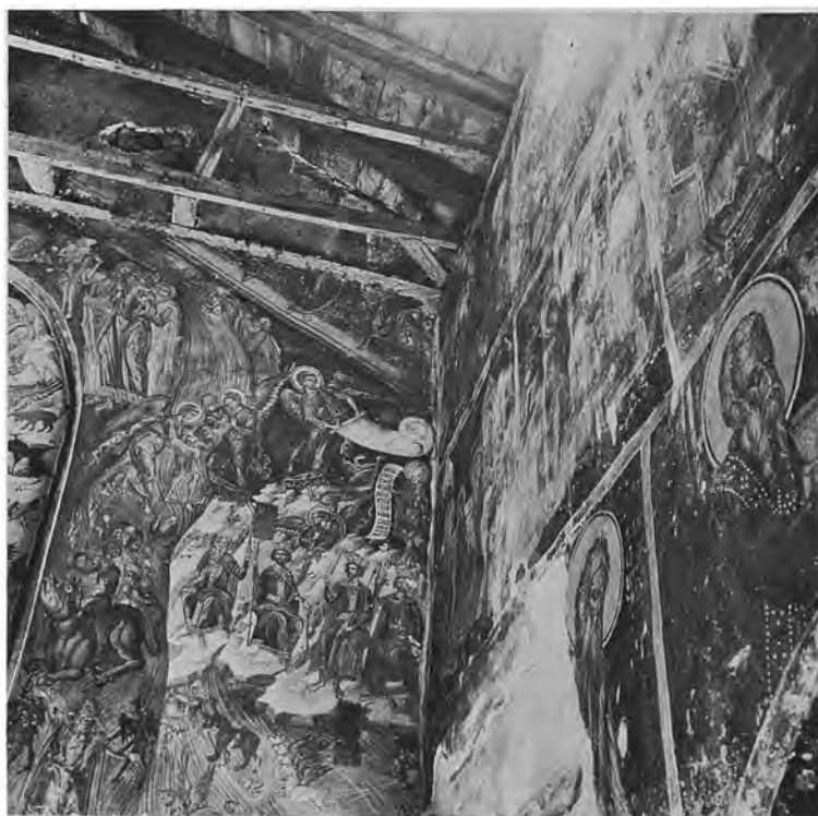
Νῆσος Ἰωαννίνων. Μονὴ Ἁγίου Νικολάου τοῦ Ντίλιου: α. Τὸ ἐσωτερικὸν τοῦ νάρθηκος πρὸς Δ., β. Μερικὴ ἄποψις τῆς Α. καὶ Ν. πλευρᾶς τοῦ νάρθηκος (κατὰ τὰς ἐργασίας)
