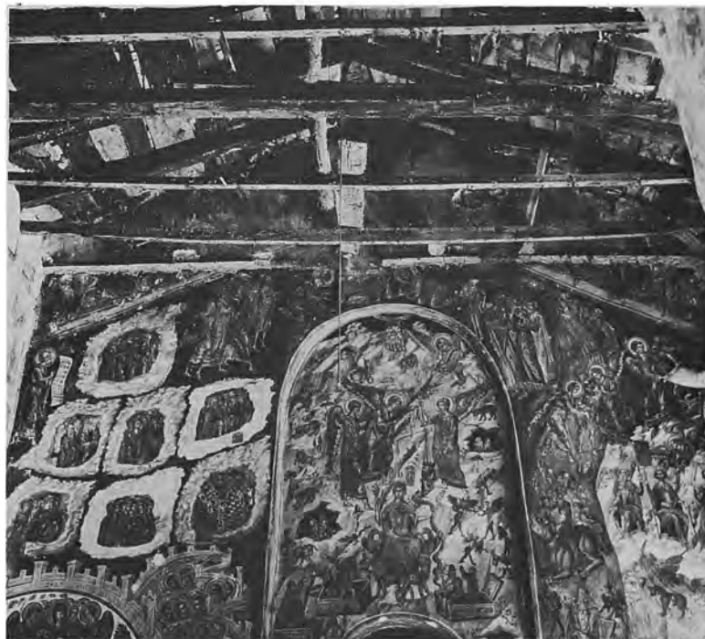
Νῆσος Ἰωαννίνων. Μονὴ Ἀγίου Νικολάου τοῦ Ντίλιου: α. Τὸ ἐσωτερικὸν τοῦ κυρίως ναοῦ πρὸς Δ. (μετὰ τὰς ἐργασίας), β. Τὸ ἐσωτερικὸν τοῦ νάρθηκος πρὸς Α. (κατὰ τὰς ἐργασίας)
