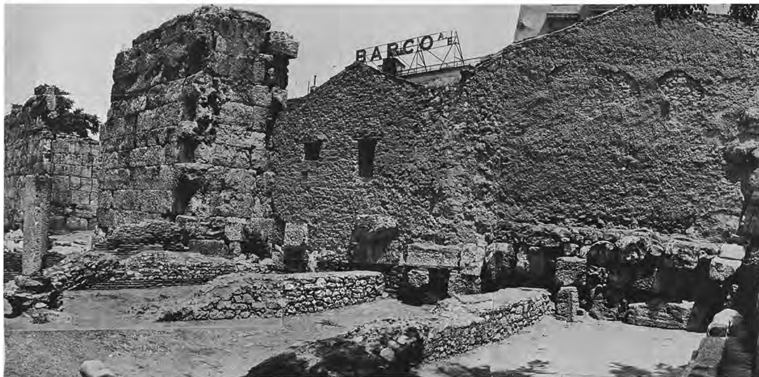
Βιβλιοθήκη τοῦ Ἀδριανοῦ. Αἶθουσα ἀκροατηρίου. Ἐκδοχὲς τοῦ Β. τμήματος τῆς αἰθούσης. Διακρί- νονται τὰ τρία σωζόμενα τοιχία διαμορφώσεως τῆς κλίσεως τῶν θόλων
