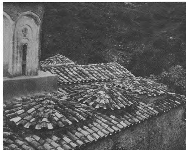
Φθιώτις. Μονή Ταξιαρχών Νεραΐδας : α - β. 'Η δυτική πλευρά πρό και μετά τὰς ἐργασίας, γ. Αί ἀποτυπώσεις τῶν παλαιῶν κεράμων ἐπὶ τῆς στέγης, δ. 'Η στέγη μετὰ τὰς ἐργασίας
