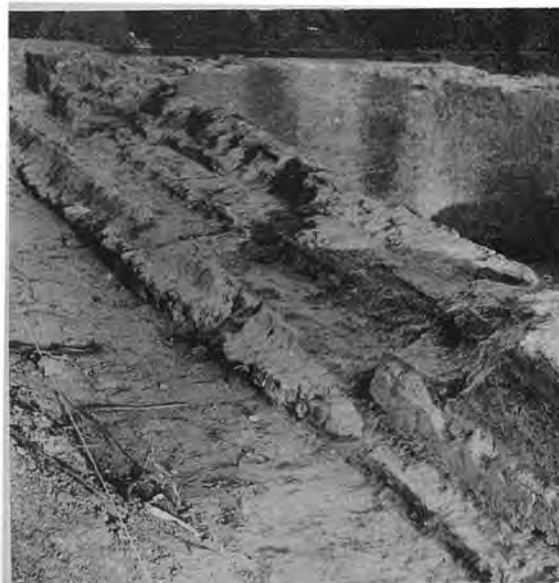
Πάτραι. Ψηλά 'Αλώνια : α. 'Αποψις από ΝΑ. του μεταξύ των δύο δεξαμενών καταφλίου, β. Λίθος εις δευτέραν χρῆσιν ἐκ τῆς νοτίας δεξαμενῆς, γ. 'Αποτυπώματα ἐκ τῆς κατασκευῆς στηθαίου τῆς βορείου δεξαμενῆς
