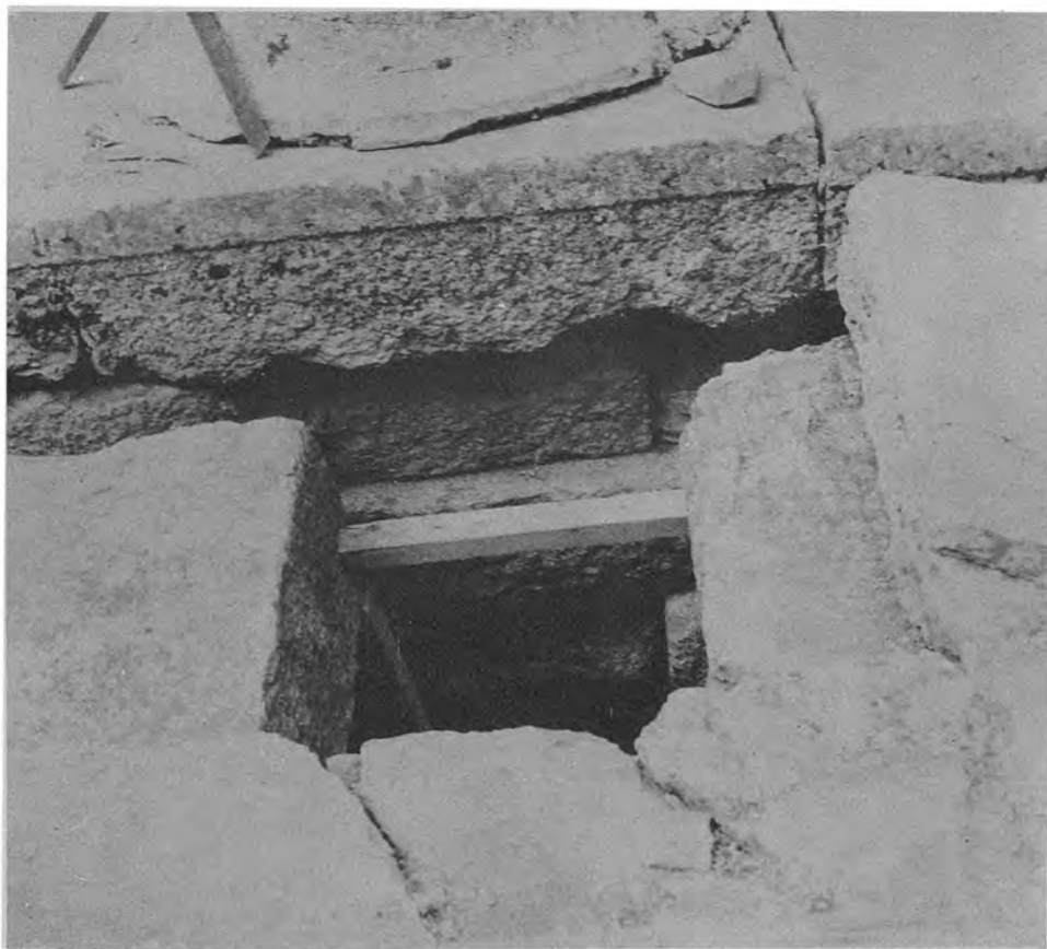
Βάσσαι : α - γ. Ευρήματα εκ του αρχαϊκού ναοῦ, δ. Κλασσικὸς ναός. Θεμελίωσις στυλοβάτου καὶ στήριξις δαπέδου σηκοῦ
