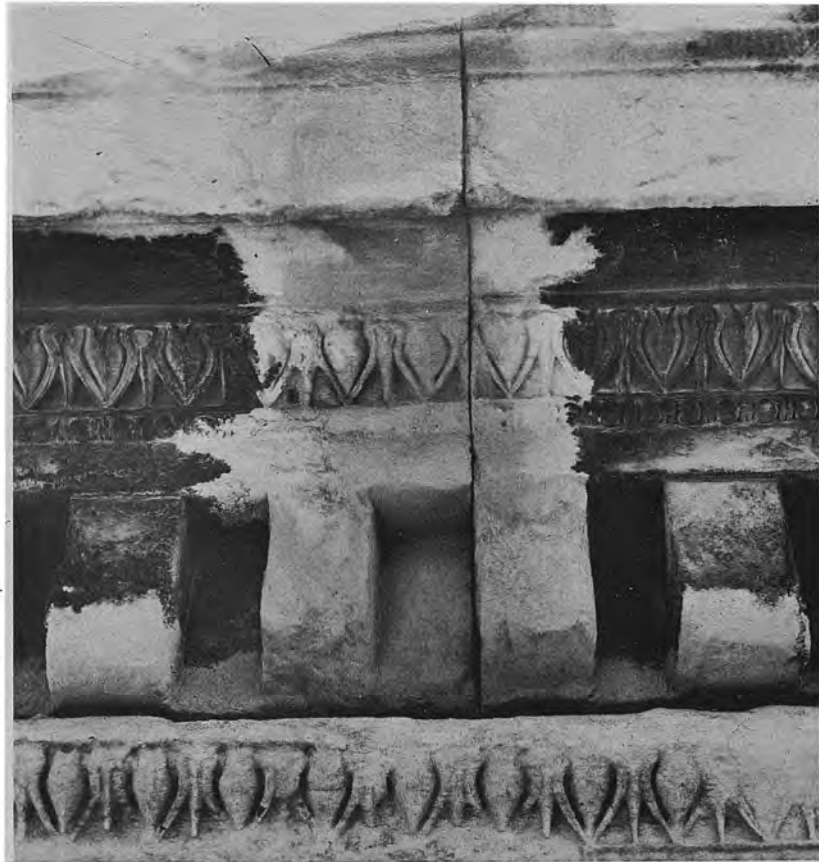
Ἀθήναι. Πρόστασις Καρυατίδων Ἐρεχθείου : α - γ. Τμήμα τῆς δυτικῆς πλευρᾶς τοῦ θριγκοῦ πρό, κατὰ τὴν διάρκειαν καὶ μετὰ τὰς ἐργασίας συντηρήσεως
