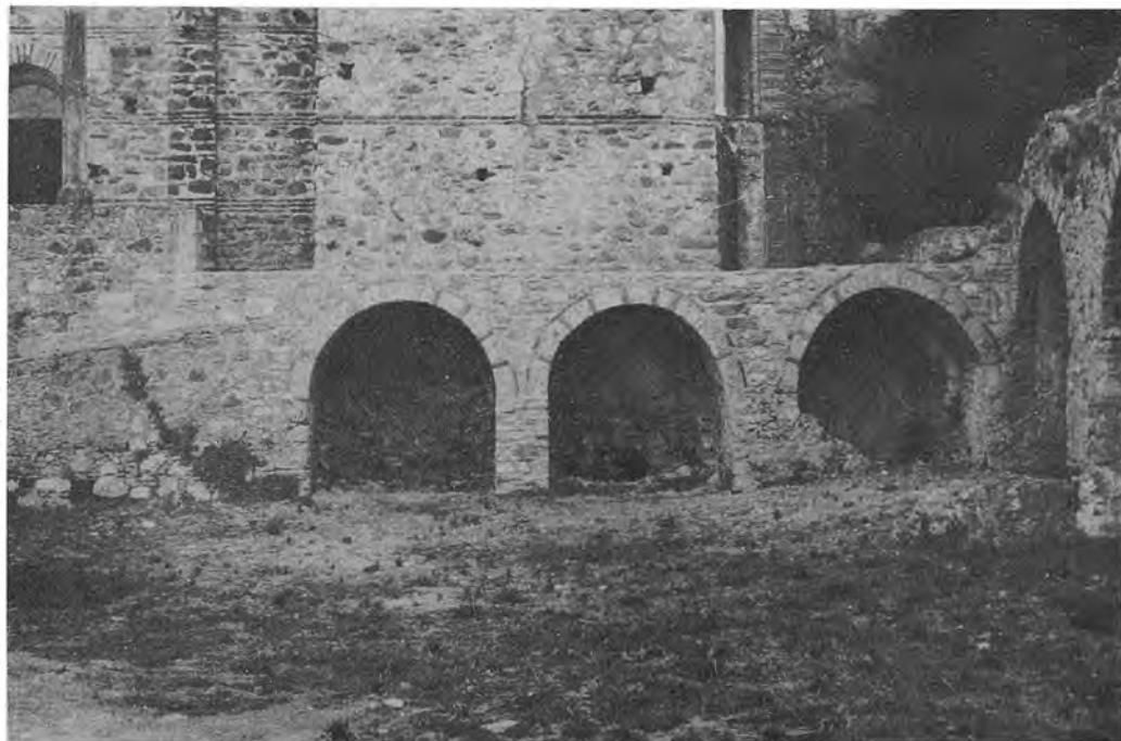
Μυστράς : α. Τμήμα οίκιας, μετά τὰς ἐργασίας, β. Ἀποκατάστασις τοξωτοῦ πλαισίου τῆς τρίτης πύλης τοῦ χώρου, γ. Ἄφεντικό. Στοά βορειοδυτικοῦ παρεκκλησίου
