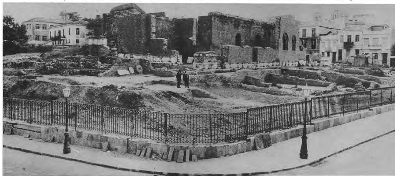
Πάτραι. Ρωμαϊκὸν Ὀδεῖον : α - β. Τμήματα τοῦ ἐν μέρει ἀναστηλωθέντος μνημείου, γ. Ὁ περὶ τὸ Ὀδεῖον χώρος κατὰ τὴν διάρκειαν τῶν ἐργασιῶν διαμορφώσεως
