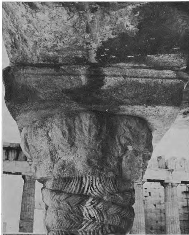
Ἀθήναι. Ἐρέχθειον : α - γ. Ἡ κάλαθος καὶ τὸ ἐπιστόλιον τῆς ΝΑ. Καρυάτιδος πρὸ, κατὰ τὴν διάρ- κειαν καὶ μετὰ τὰς ἐργασίας συντηρήσεως
