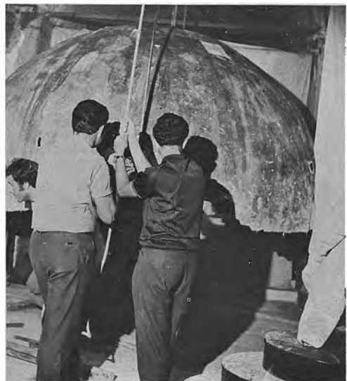
Νάξος. Πρωτόθρονος : α. Έργασίαι έρεύνης διά την διαπίστωσιν διπλού τοιχογραφικού στρώματος εις τόν τρούλλον, β. Όπλισμός νεωτέρου στρώματος τρούλλου κατά τάς έργασίας άποκολλήσεως, γ. Τό δεύτερον στρώμα τοιχογραφίας του τρούλλου κατά την καθέλκυσιν
