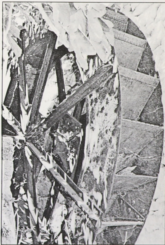
Η φτερωτή ήταν το μέσο με το οποίο το νερό κινούσε τους υδρόμυλους για την έκθλιψη του ελαιοκάρπου, πριν από πολλά χρόνια. ✓
