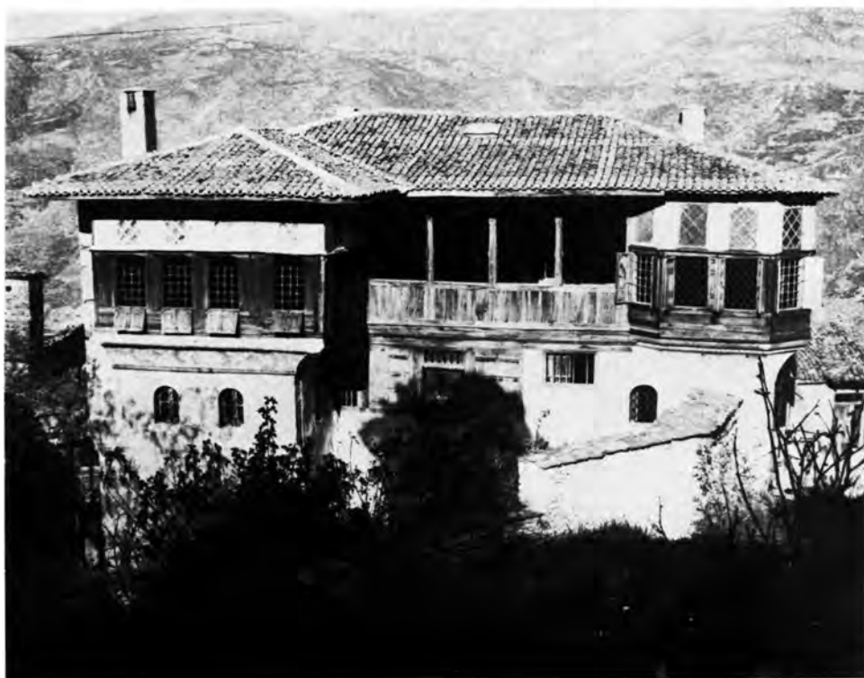
Ἀμπελάκια. Ἀρχοντικὸν Γεωργίου Σβάρτς : α - β. Ἡ νοτιὰ ὄψις, πρὸ καὶ μετὰ τὴν ἐπισκευὴν
