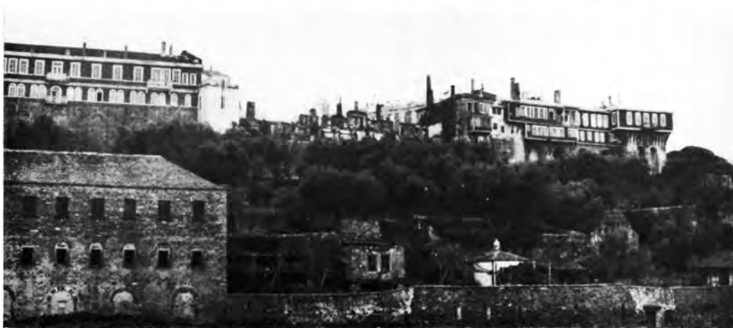
Ἅγιον Ὄρος. Ἰ. Μ. Βατοπεδίου : α. Τμήμα διαδρόμου, μετά τὴν πυρκαϊάν, β. Τμήμα τῆς πρὸς τὴν θάλασσαν ὄψεως, μετά τὴν πυρκαϊάν, γ. Ἡ πρὸς τὴν θάλασσαν ὄψις. Εἰς τὸ κέντρον τὸ ἀποτεφρωθὲν τμήμα
