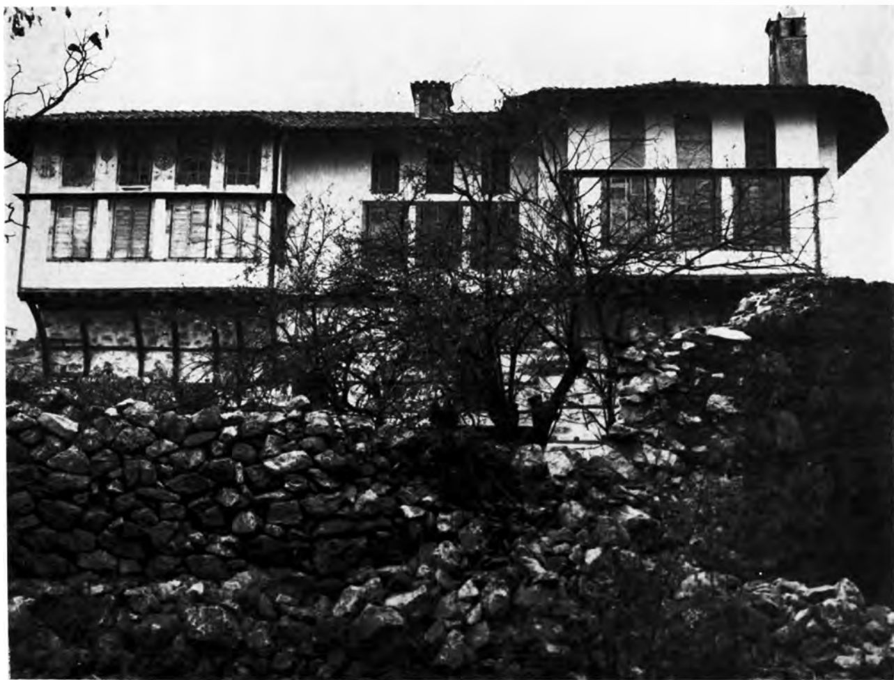
Σιάτισσα. Τὸ ἀρχοντικὸν τῆς « Πούλκως » : Ἡ νοτία ὄψις μετὰ τὴν πρώτην φάσιν τῶν ἐργασιῶν ἐπισκευῆς
