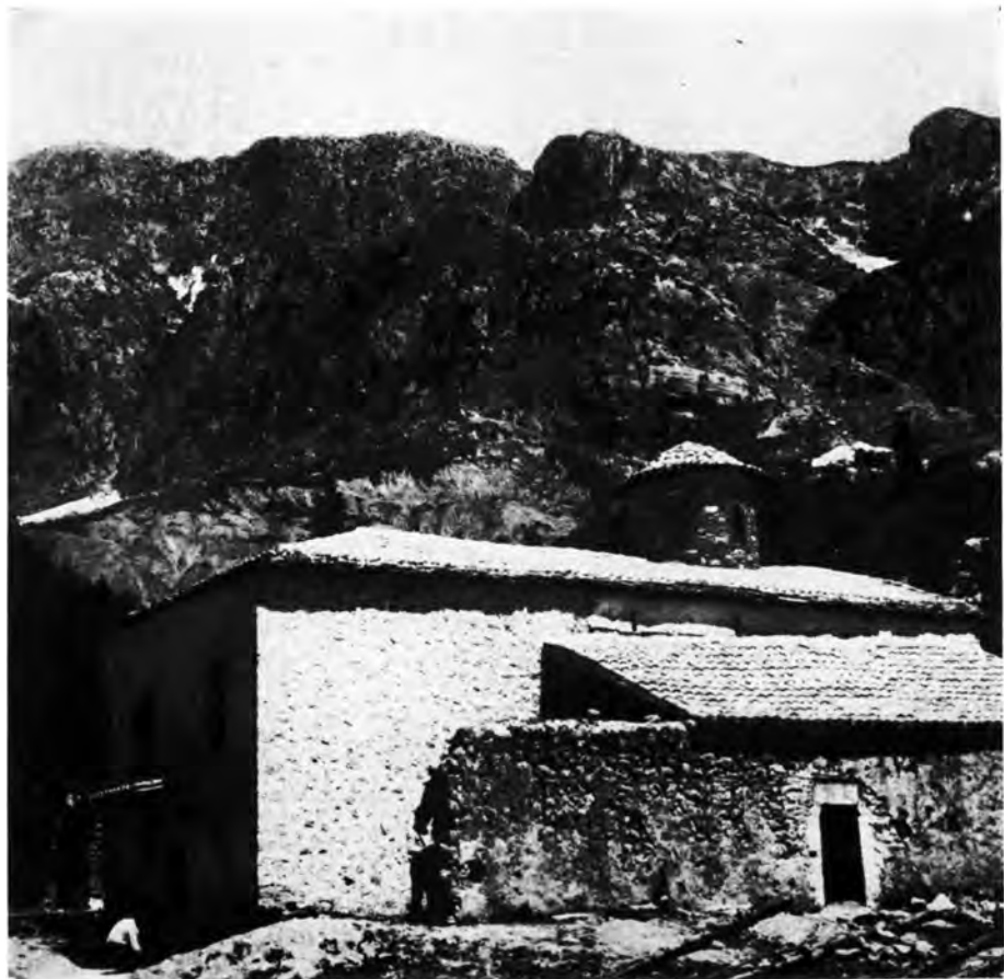
Ἡπειρος : α. Ζερβοχώριον Θεσπρωτίας. Ναός Ἁγίου Δημητρίου. Τὸ ἱερόν, β. Ἴαρυτα. Ἰμαρὲτ Τζαμί. Στέγη μετὰ τὴν ἀποκατάστασιν, γ. Ζερβοχώριον Θεσπρωτίας. Ὁ ναὸς τοῦ Ἁγίου Δημητρίου μετὰ τὴν ἀποκατάστασιν
