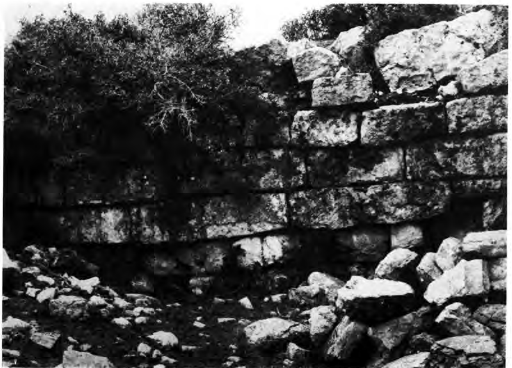
Άκαρνανία: α. Φοίτιαι. Ό ναός της Άγίας Δευτέρας, β. Ό τοίχος της δυτικής πλευράς ύδατοδεξαμενής
