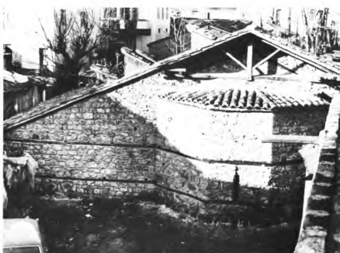
Βέροια. Ναός Αγίου Γεωργίου: α-γ) Ανατολική άποψη πριν, κατά τη διάρκεια και μετά τις εργασίες, αντίστοιχα.
