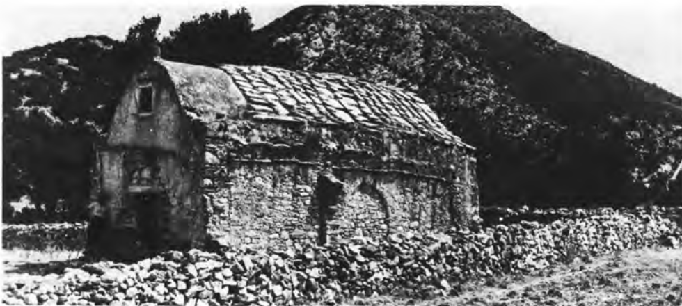
Νάξος: α) Μονή του Χρυσοστόμου κοντά στη Χώρα. Ο πύργος, β-γ) Ναός Αγίου Γεωργίου στο Πέρα Χαλκί. Η δυτική πλευρά και η άποψη του ναού από Β. μετά τις εργασίες, δ) Ναός Αγίου Στεφάνου στον Κάτω Μαραθό. Άποψη του ναού από ΝΑ. πριν τις εργασίες.
