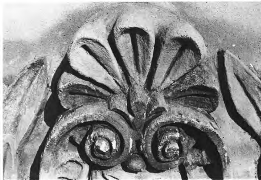
α) Δράμα. Οδός Αγίας Βαρβάρας. Βυζαντινός λουτρόνας, β-γ) Καβάλα. Η Δημοτική Καπναποθήκη πριν από τις εργασίες και λεπτομέρεια του διακόσμου της κατά τη διάρκεια των εργασιών.
