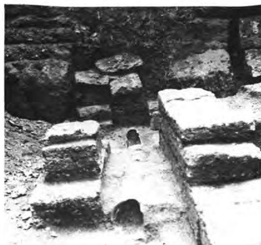
Ρόδος: α-β) Οδός Κέννεντυ (οικόπεδο Αρ. Βουδούρη-Γιαννακόπουλου). Ο καμπύλος τοίχος από ΒΑ. του ύστερου μνημειακού κτίσματος και τμήμα του ανατολικού ορίου της Ρ 26α από Δ., γ) Οδός Κέννεντυ 39. Άποψη αγωγού της οδού Ρ 10 από Δ.
