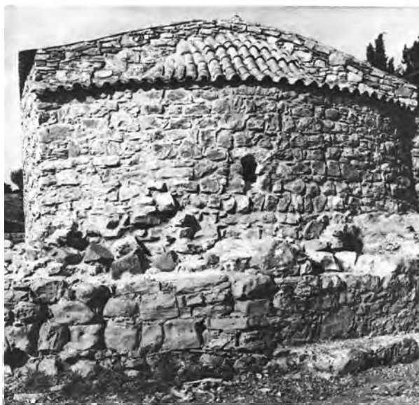
Ρόδος: α-β) Μεσαιωνικό Τείχος. Η πύλη του Αγίου Παύλου, πριν και μετά τη συντήρηση, γ) Κοίμηση Παναγίας Μεσαναγρού. Η ασίδα του Ιερού Βήματος μετά τη συντήρηση.
