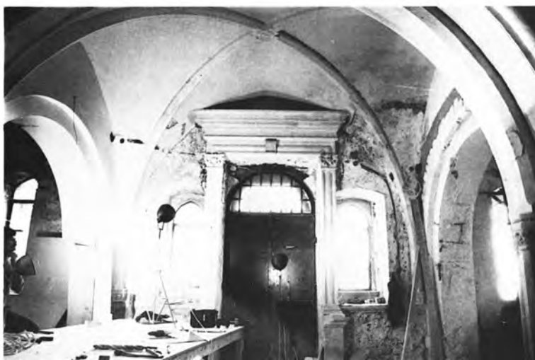
Χανιά, Εκκλησία Αγίου Φραγκίσκου: α-β) Ο χώρος Δ κατά τη διάρκεια των εργασιών και γενική άποψη μετά τις εργασίες, γ) Ο χώρος Θ κατά τη διάρκεια των εργασιών.
