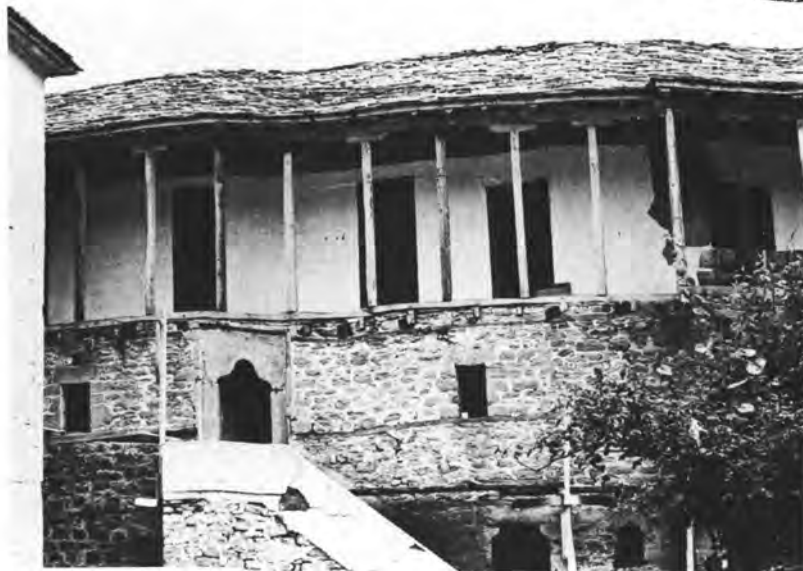
α) Σιάτιστα. Το αρχοντικό Μανούση από Β. μετά τις εργασίες, β-γ) Βυθός Κοζάνης. Μονή Αγίας Τριάδας. Η νότια πτέρυγα των κελιών κατά τη διάρκεια των εργασιών και λεπτομέρειά τους (από την εσωτερική αυλή) μετά τις εργασίες.
