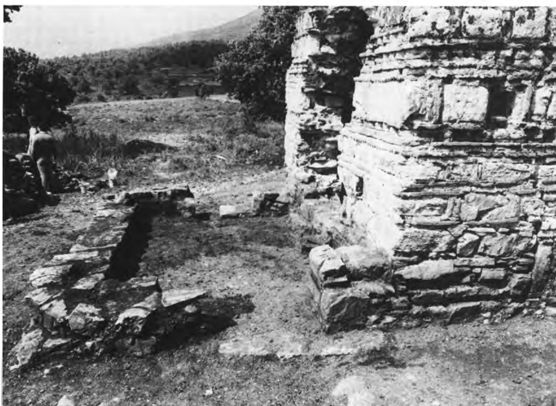
Ρίβιο: α-β) Άγιος Στέφανος κατά τη διάρκεια των εργασιών.
