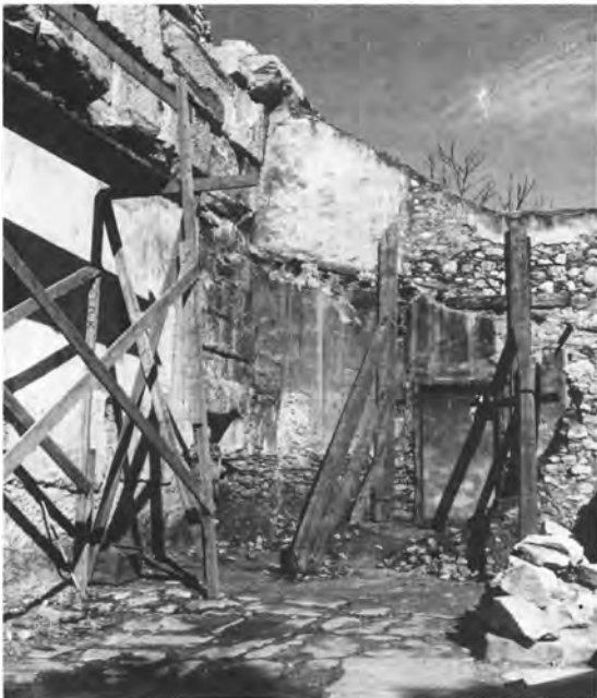
Αθήνα. Βιβλιοθήκη Αδριανού: α-β) Η δυτική όψη πριν και μετά τις εργασίες, γ) Αντηρίδα πριν από τις εργασίες.
