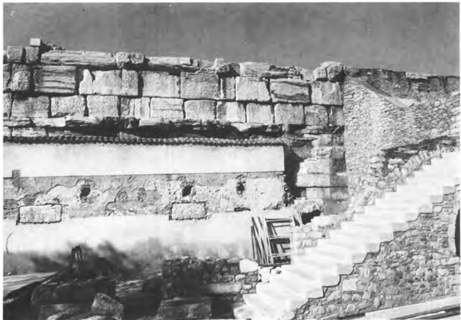
Αθήνα. Βιβλιοθήκη Αδριανού: α) Αντηρίδα μετά τις εργασίες, β-γ) Κλιμακοστάσιο πριν και μετά τις εργασίες.
