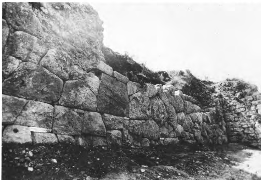
Κάστρο Ρωγών: α-β) Στερεωτικές εργασίες.
