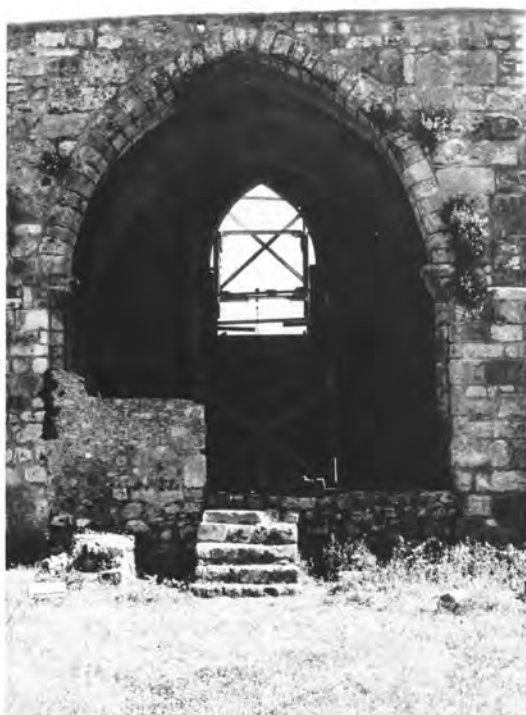
Ανδραβίδα. Ναός Αγίας Σοφίας: α) Η ανατολική όψη μετά τις εργασίες αποκατάστασης, β) Εργασίες στερέωσης στο εσωτερικό, γ) Διάνοιξη νότιου διαμερίσματος του Ιερού.
