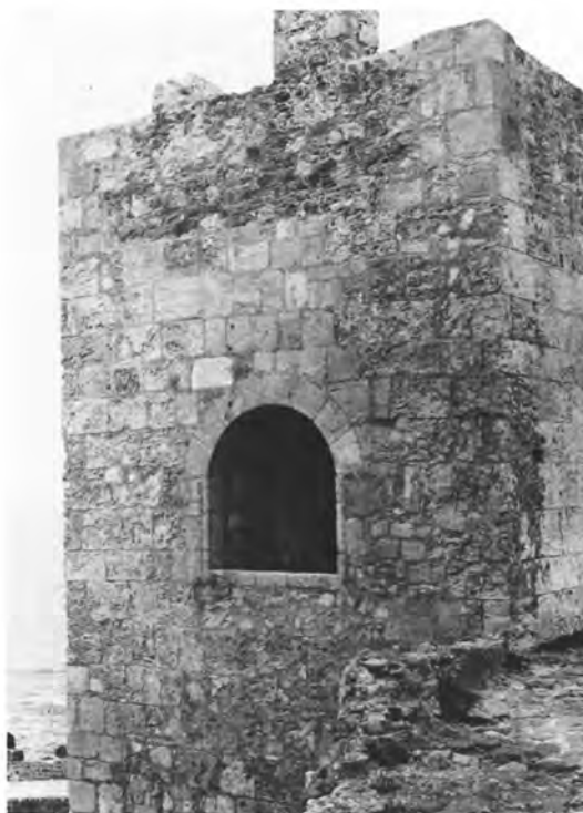
Μεθώνη: α-γ) Η νότια επιθαλάσσια πύλη από το εσωτερικό μετά τις εργασίες και ο νοτιοανατολικός πύργος του νότιου επιθαλάσσιου τείχους πριν και μετά τις εργασίες.
