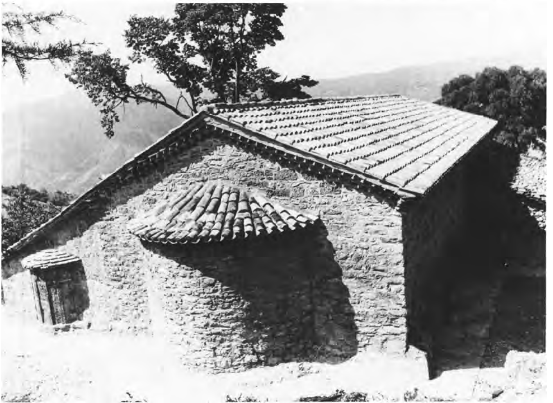
Κράψη. Ο ναός του Αγίου Νικολάου: α-β) Πριν και μετά τις εργασίες.
