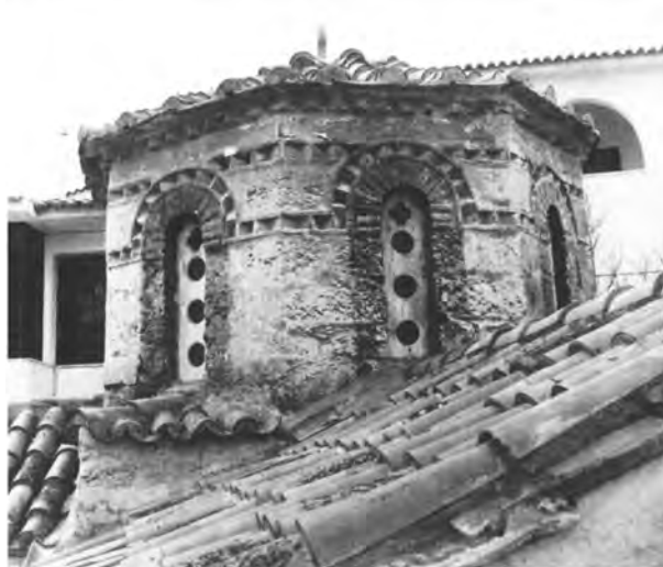
Μέγαρα: α-γ) Άγιος Ιερόθεος. Δυτική προσθήκη κατά την αποκατάσταση, αρμός τοιχοποιίας ναού και προσθήκης και ο τρούλος μετά τις εργασίες.
