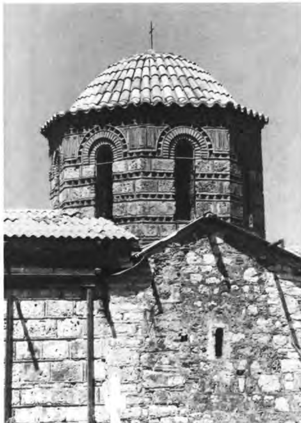
Μανωλάδα. Παλαιοπαναγιά: α-β) Ο τρούλος κατά τις εργασίες καθαρισμού της τοιχοδομίας και μετά τις εργασίες.
