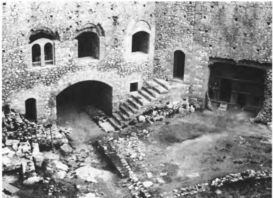
α) Καλάβρυτα. Παλαιομοναστήρο Αγίας Λάρας. Καθολικό, δυτική θύρα, β-γ) Χλεμούτσι. Στερέωση και αποκατάσταση κλίμακας μεταξύ αιθουσών Α-Γ.
