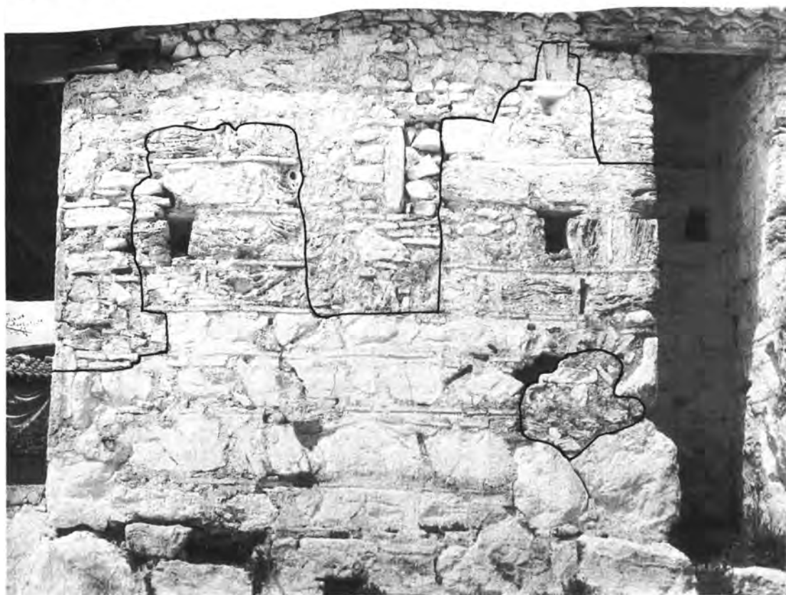
Ναός Μεταμορφώσεως στη Μεταμόρφωση. Η νότια όψη (η μαύρη γραμμή δείχνει τη σωζόμενη βυζαντινή τοιχοποιία: α) Νότια πλευρά του νότιου σκέλους του σταυρού, β) Νότια πλευρά του κάρθηκα.
