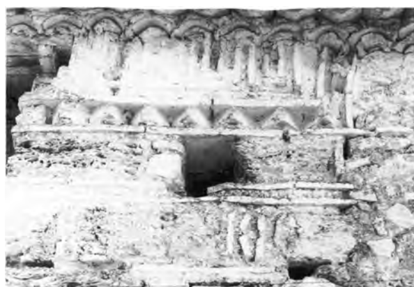
Ναός Μεταμορφώσεως στη Μεταμόρφωση: α-β) Η τοιχοποιία της βόρειας όψης, γ) Υπολείμματα ζώνης μαιάνδρου στη νότια πλευρά του νότιου σκέλους του σταυρού.
