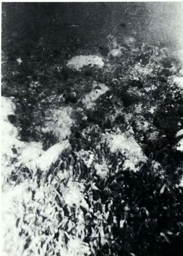
Εικ. 9. Λεπτομέρεια από την πάνω επιφάνεια της ύψαλης λιθορριπής.
