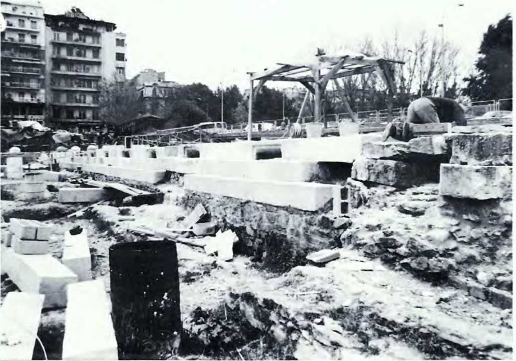
Εικ. 10. Άποψη της νότιας κρηπίδας με τις φωτιστικές θυρίδες.
