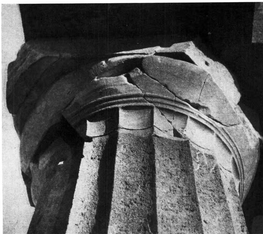
Βραυρών: α. Κιονόκρανον τοῦ κίονος α, μετὰ τὴν ἀποκατάστασιν καὶ τὴν ἀναστήλωσιν. Ὅψις ἀπὸ Δ., β. Κιονόκρανον τοῦ κίονος β, μετὰ τὴν ἀποκατάστασιν καὶ τὴν ἀναστήλωσιν. Ὅψις ἀπὸ Δ.
