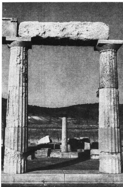
Βραυρών: α. Κιονόκρανον τοῦ κίονος δ, μετὰ τὴν ἀποκατάστασιν καὶ τὴν ἀναστήλωσιν. Ὅψις ἀπὸ Ν., β. Τὸ μόνον ἀρχαῖον ἐπιστύλιον καὶ οἱ κίονες ι καὶ κ, μετὰ τὴν ἀναστήλωσιν
