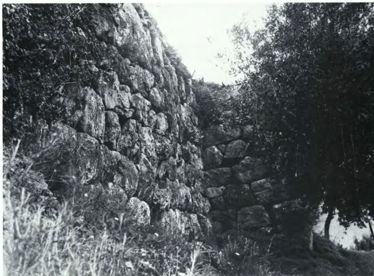
Τυρός: α) Γενική άποψη του Κάστρου από Β.ΒΔ., β) Τμήμα της βόρειας πλευράς του οχυρωτικού περιβόλου.
