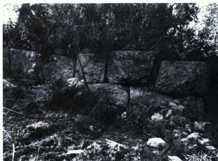
Τσιόροβος Δολιανών: α) Γενική άποψη από το Ελληνικό Άστρος, β-γ) Τμήμα τείχους και η βόρεια πλευρά του πύργου στη δυτική πλευρά του περιβόλου.
