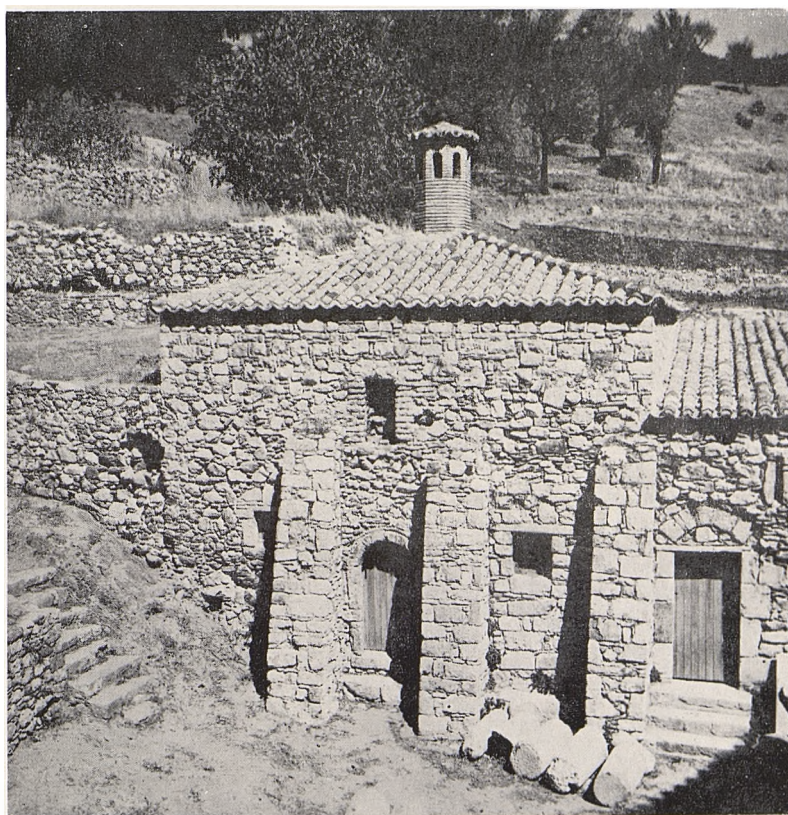
α. Κωδωνοστάσιο Μονής Ὁσίου Λουκά. Σταυροθόλιο τοῦ κατωτάτου ἡμιυπογείου χώρου, β. Φωτάνημα τῆς Μονῆς Ὁσίου Λουκά
