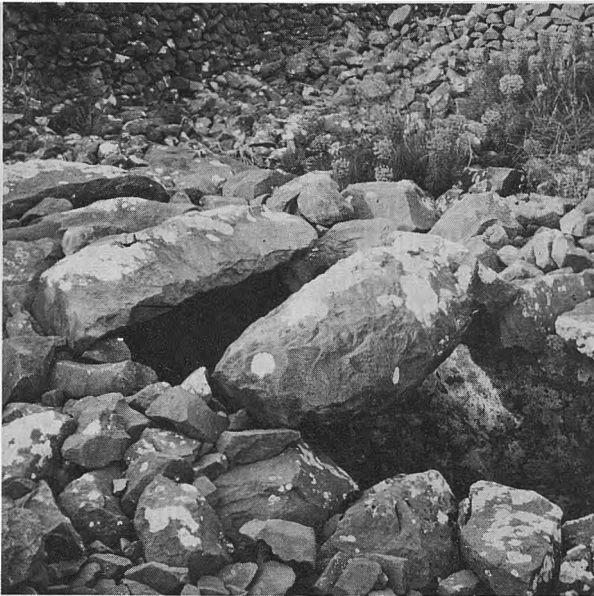
Είκ. 2. Ριγανόχωρα. Κάλυψη δεξαμενής νερού με μακρινόνια.
