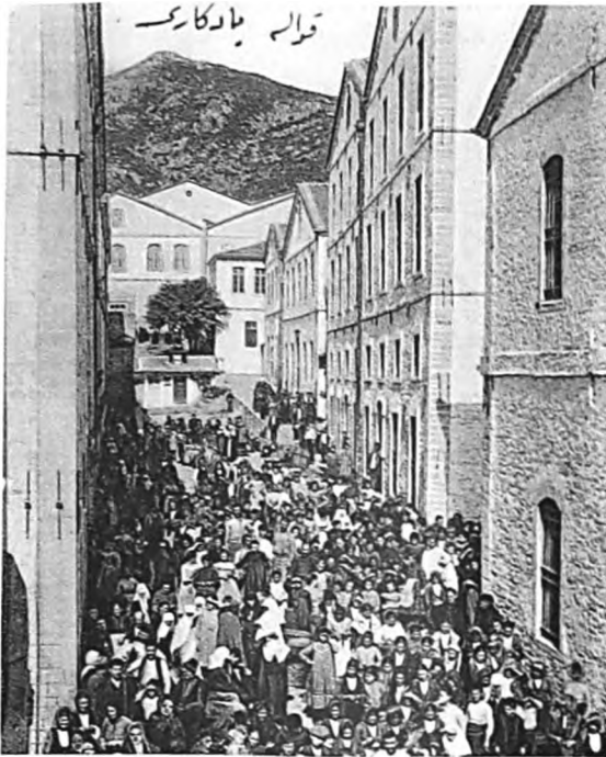
Souvenir de Cavalla Sortie des ouvriers des tabacs de la maison M. L. Herzog & Co.
