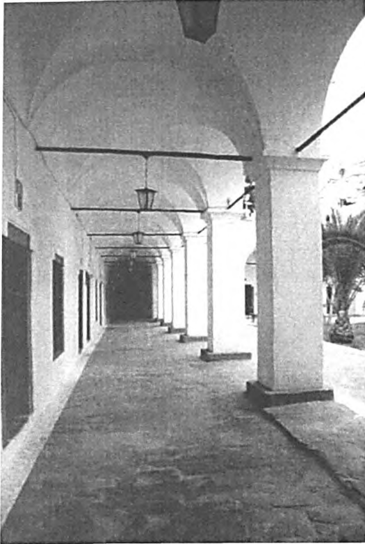
Τμήμα του πρώτου μεντρεσέ του Ιμαρέτ.
