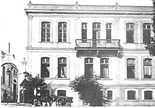
Το οθωμανικό Διοικητήριο (1896), σημερινό κτίριο Δικαστηρίων (αρχείο Ι.Α.Α.Κ. κ. Ν. Ρουδομύτης).
