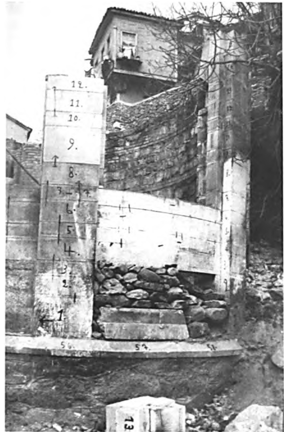
Φωτογραφίες από την ανέγερση του Μεγάρου της Διεύθυνσης του Ιμαρέτ (ΓΑΚ - Αρχεία Ν. Καβάλας).
